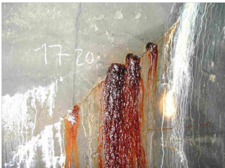
Figura 4: fessura con concrezioni di depositi bianchi di calcite e bruno-rossastri
