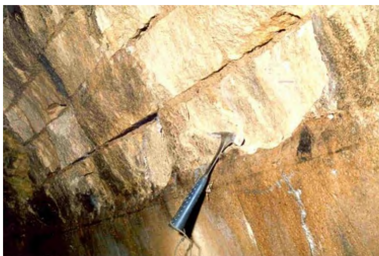
Figura 2: esfoliazione di muratura calcarea oolitica fragile e sensibile al gelo
