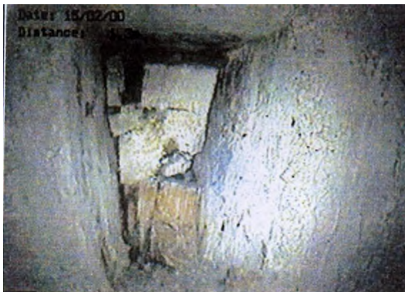
Figura 2: esempi di canali di drenaggio bloccati con detriti del sito (video-endoscopia)
