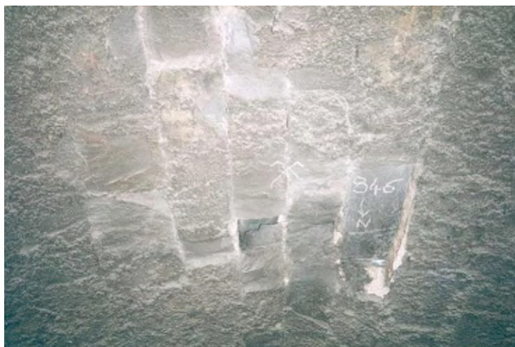
Figura 1: diagramma di distacco di pietra sulla calotta (notare l'assenza di malta tra le pietre che quindi si toccano; la caduta di una lastra dalla pietra 1 destabilizza le lastre delle pietre 2 che erano precedentemente tenute in posizione (la pietra 1 svolgeva il ruolo di chiave); se la pietra dopo il distacco suona ancora cava, questo significa che si stanno formando nuove superfici di distacco, mostrate dalle linee tratteggiate).
