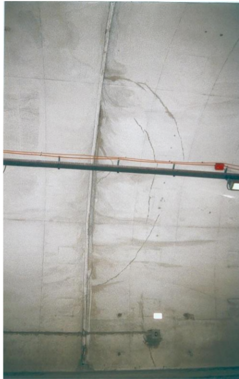
Figura 1: crepe curve concentrate al piedritto (il processo di costruzione è avvenuto da destra verso sinistra)
