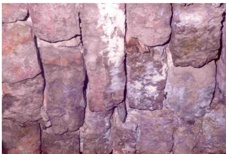
Figure 2: disintegrazione dei letti, pietre in contatto solo tramite porzioni localizzate
