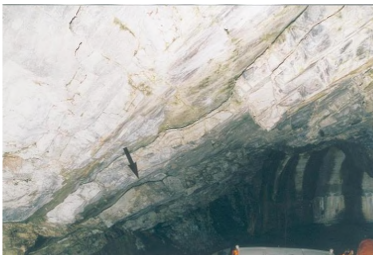
Figure 2: lastre allentate secondo un angolo di 45 gradi
