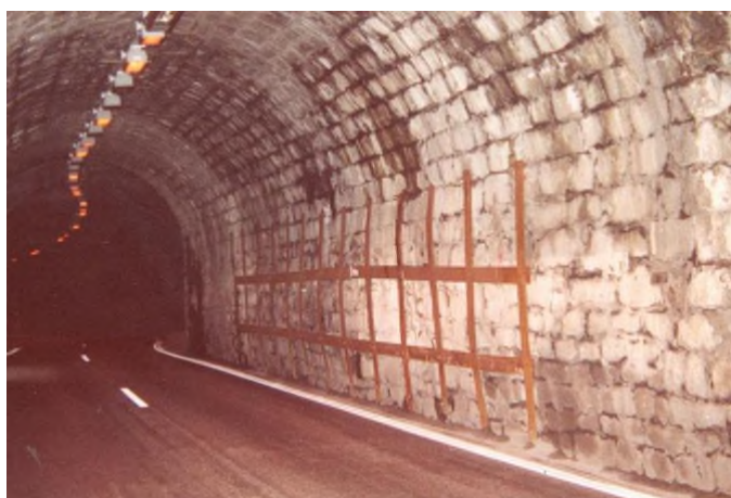
Figura 1: una parete laterale sporgente, rinforzata da ancoraggi e piastre di legatura
