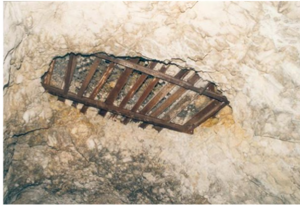
Figura 1: Griglia metallica utilizzata come protezione contro caduta di materiali poco consolidati dal carso
