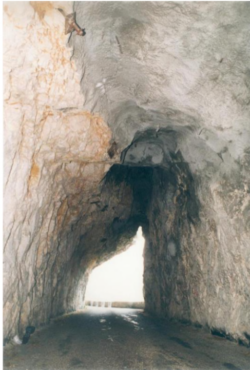
Figura 3: instabilità residua rinforzata con calcestruzzo spruzzato nell'area laterale
