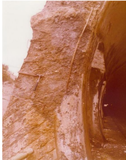
Figura 4: muro laterale in c.a. congelato
