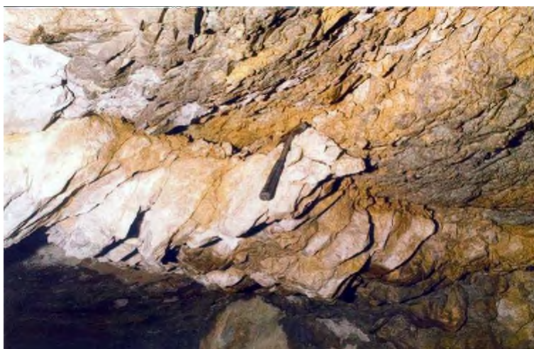
Figura 1: massa fratturata separata dalla roccia circostante da uno strato argilloso o da un "ponte di roccia instabile" (la pulizia è possibile come misura iniziale)
