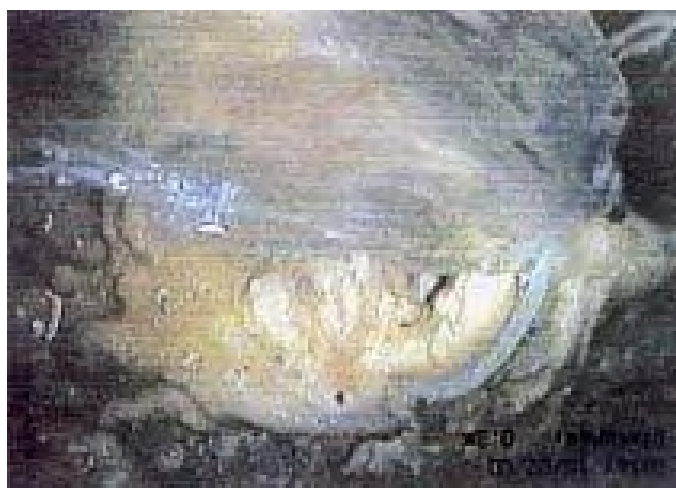
Figura 2: video-endoscopia di uno scarico in PVC bloccato da accumuli calcarei
