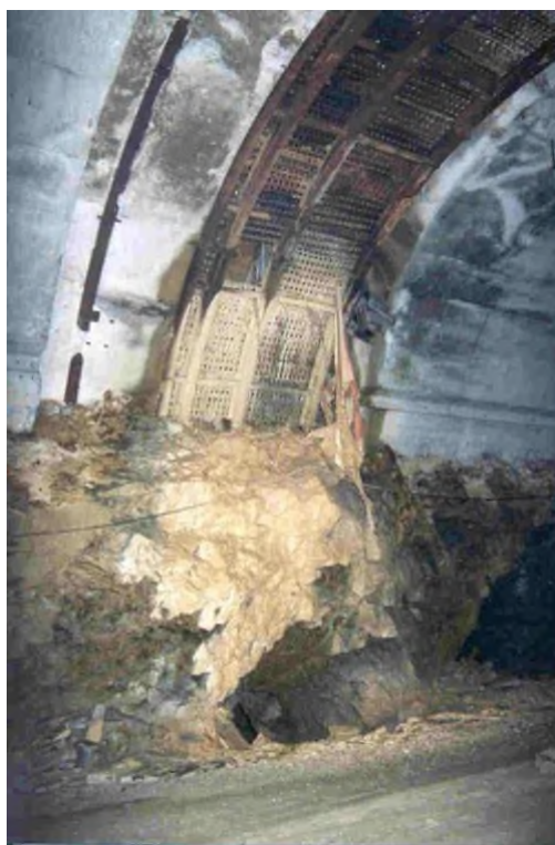
Figura 1: concrezioni calcaree che incrostano l'apertura di un carso attivo in un tunnel abbandonato
