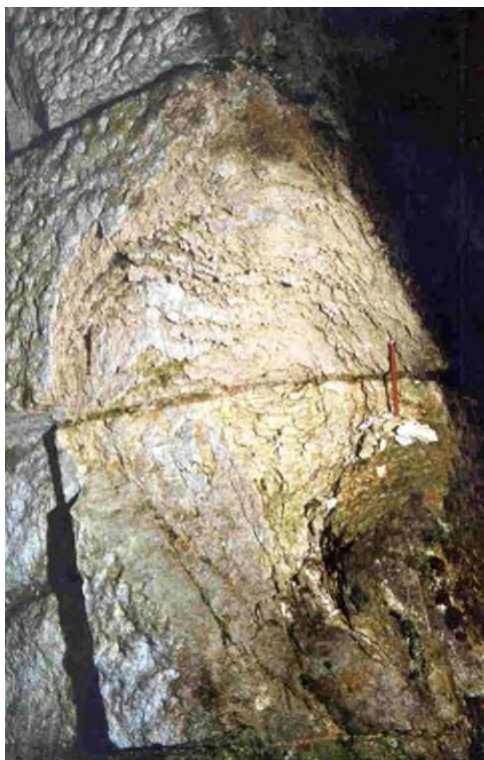
Figura 1: effetti dell'azione del gelo su grandi pietre calcaree oolitiche
