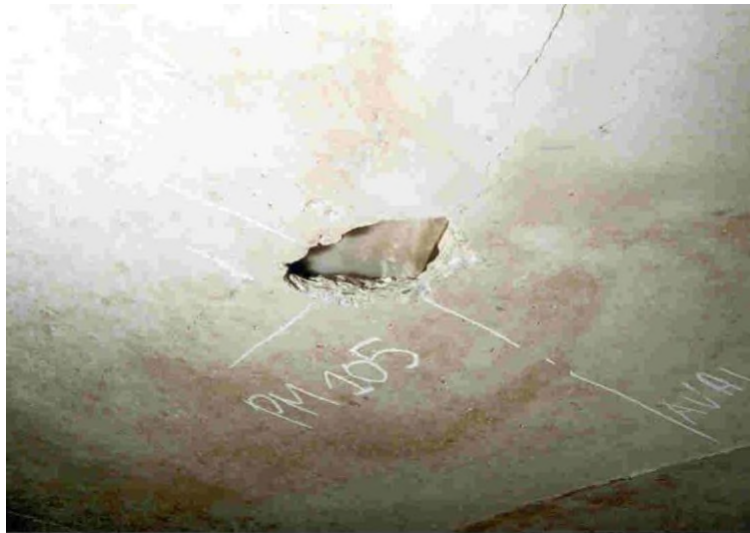
Figura 1: membrana ripiegata (area di suono vuoto localizzata)
