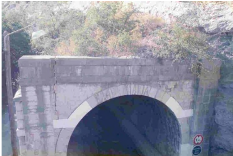
Figura 1: fessurazione e rotazione laterale di un baldacchino
