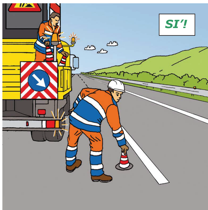
Figura 59 – Posizionamento dei coni o defleco: comportamento corretto
