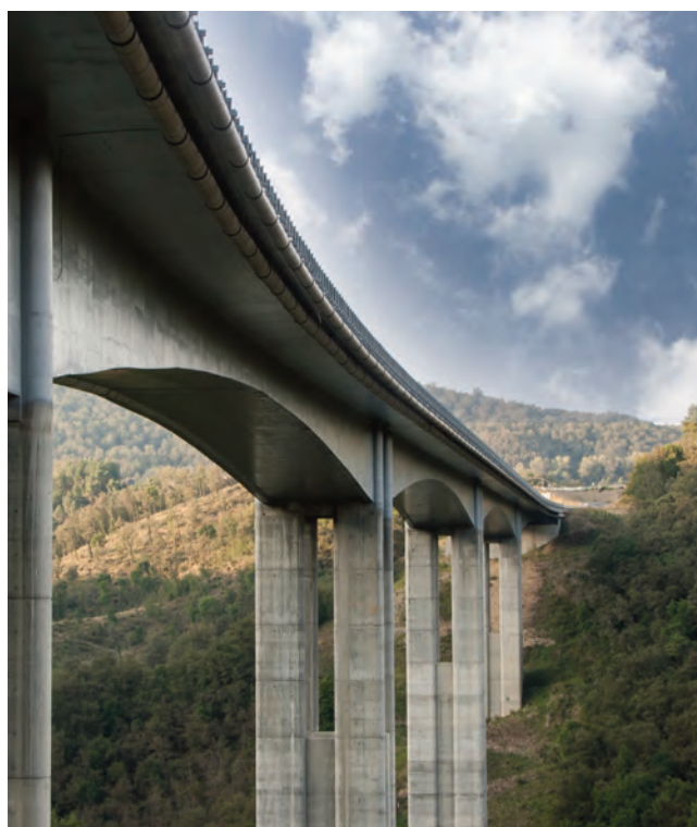
Il Viadotto Aglio, in costruzione e a opera finita
