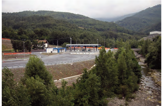
Il nuovo casello di Badia in costruzione
