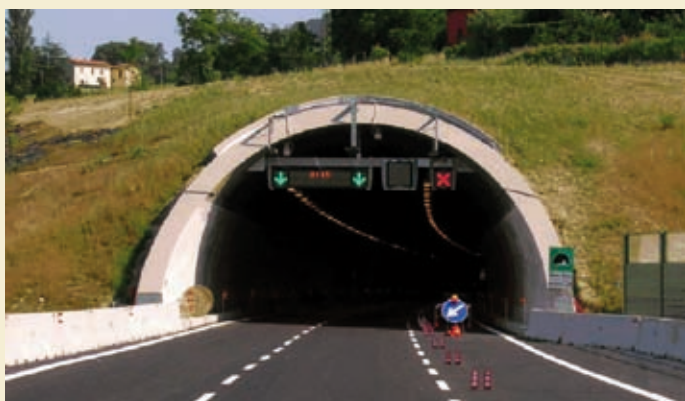
Sistemi di segnalazione all'imbocco di una galleria.
