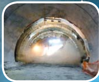
Foto piccole: la sequenza dell'abbattimento del diaframma della galleria.
