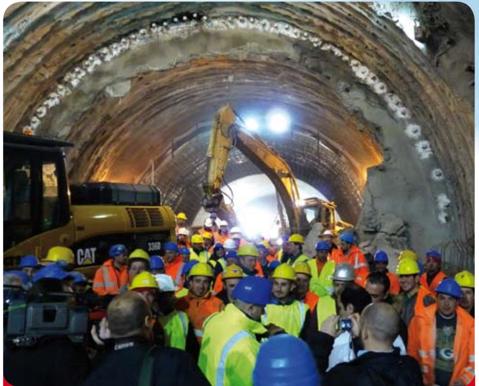
La folla attraversa il varco, dopo l'abbattimento del diaframma.
